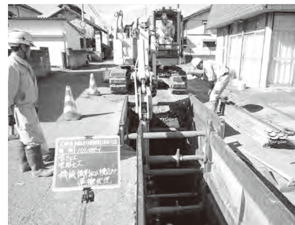
進む下水道の新設普及工事
