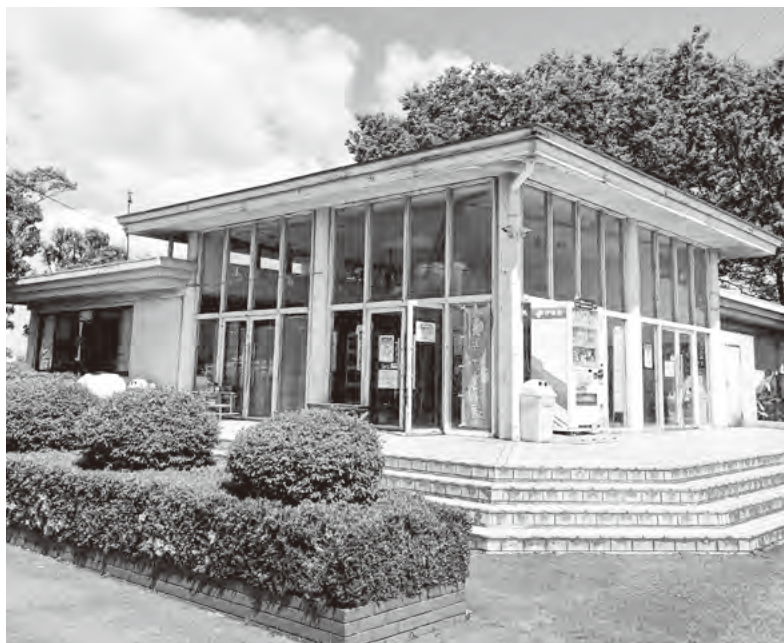
総合運動公園管理棟を誰もが利用しやすい施設へ
