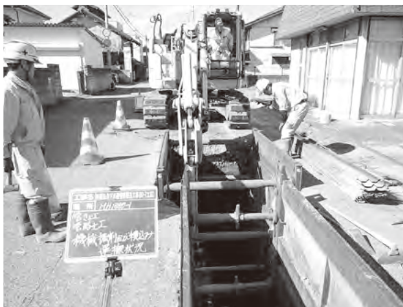
進む下水道の新設普及工事
