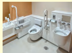
改修されたトイレ
