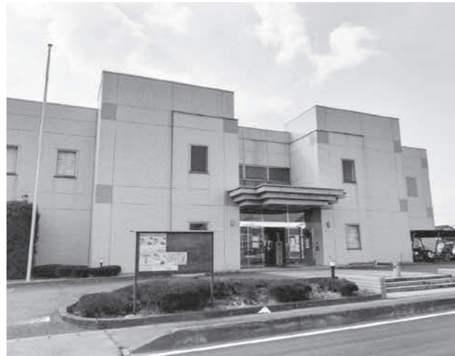
大規模改修を行う海洋センター
