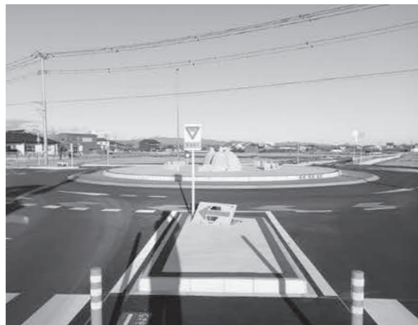
ラウンドアバウト。画期的な環状交差点 (前橋市下長磯町)
