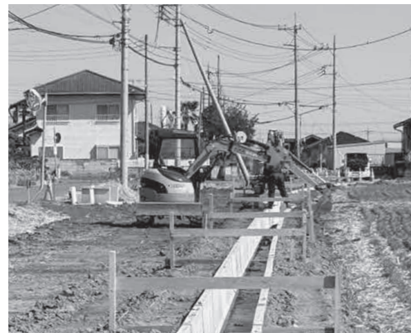
下茂木橋に向けて進む町道103号線道路改良事業
