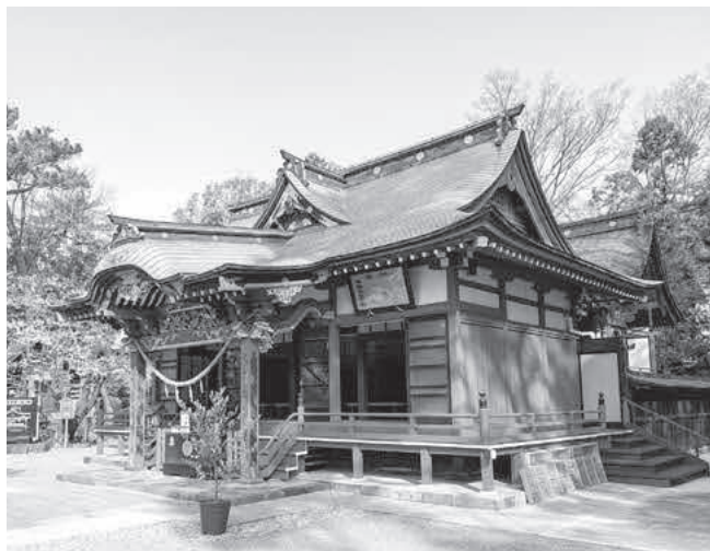
屋根の保存修理を行う玉村八幡宮拝殿
