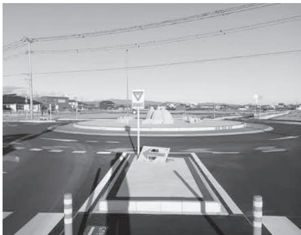
ラウンドアバウト。画期的な環状交差点 (前橋市下長磯町)
