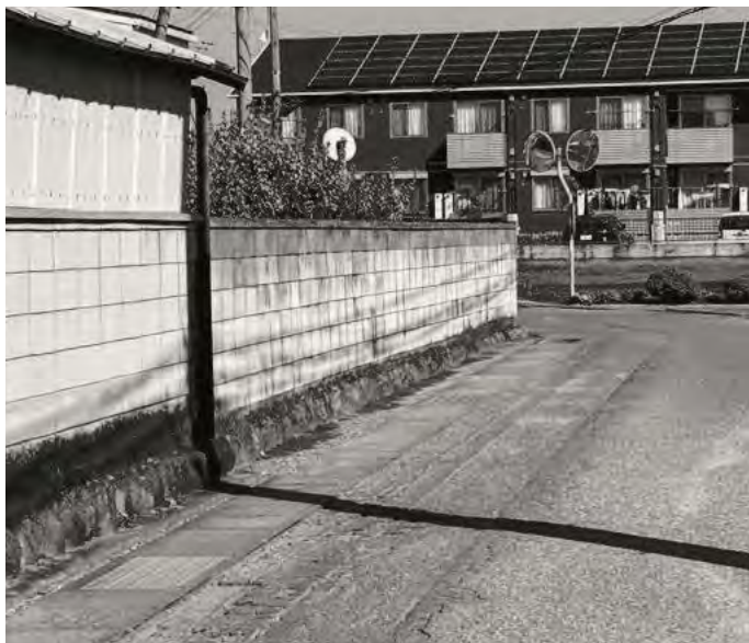
ブロック塀を一部カットし見通しのよい 交差点に道路改良（板井区内）
