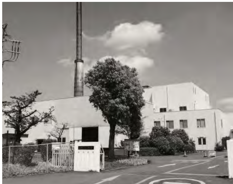
安全かつ安定的な焼却運転のための 年次整備工事を実施
