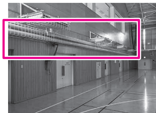
配管を守る防球ガードを追加で設置
