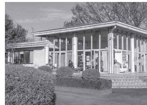
老朽化が著しい総合運動公園管理棟。多くの町民が1日も早い改修工事を待ち望んでいる
