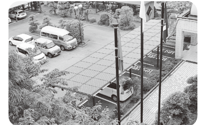
カーポートの上に設置した太陽光パネル
