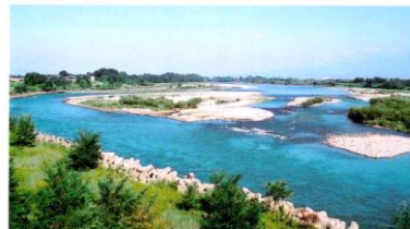
利根川—五料橋から上流を望む—
