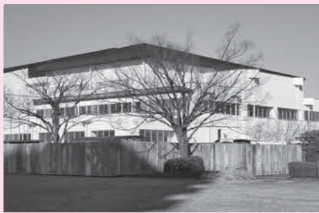
改修工事が進む社会体育館
