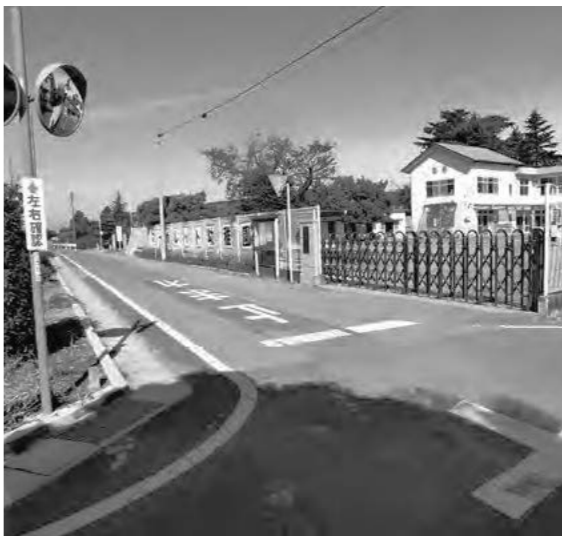
側溝改良工事が完了したマーガレット幼稚園前
