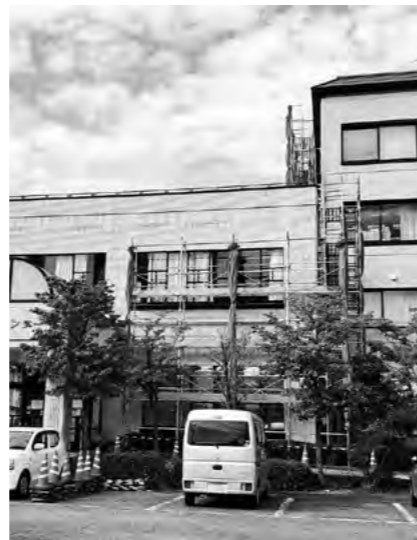
改修工事が進む役場庁舎・保健センター
