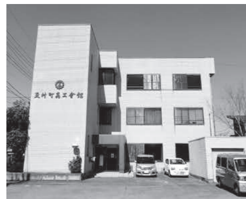
改修予定の商工会館
