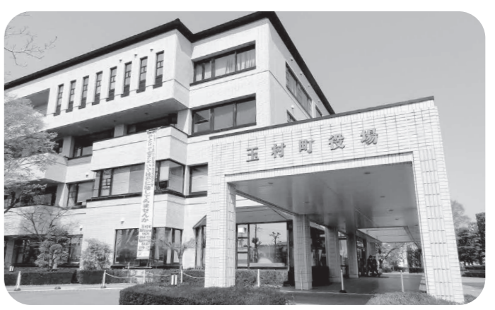
今後改修が必要な役場庁舎
