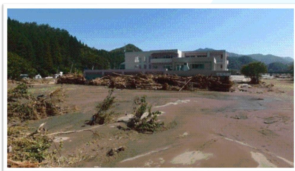
平成28年台風第10号による被害状況
