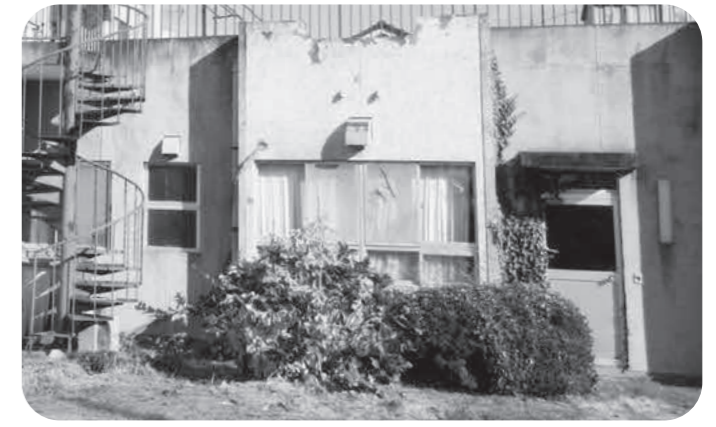
解体予定の空き家
