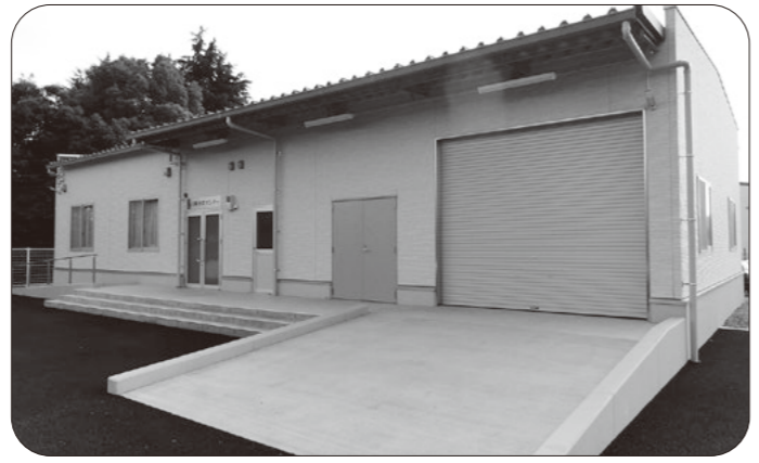
防災倉庫としての機能を持つ水防センター
