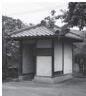
外便所 (昭和元年)
