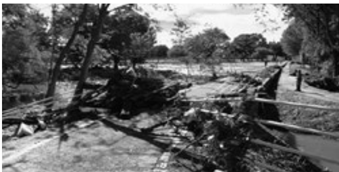
令和元年 台風19号の被害状況(川井)
