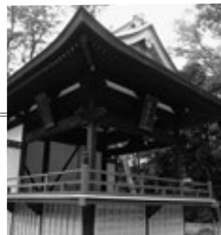
改修した玉村八幡宮神楽殿
