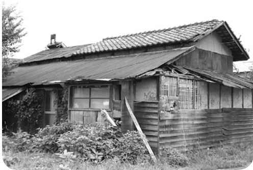
急がれる空き家対策
