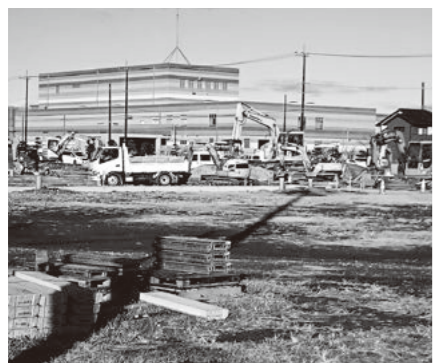
文化センター周辺の次期分譲地造成工事
