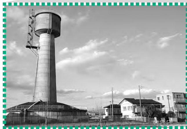
住宅等に隣接する高架水槽
