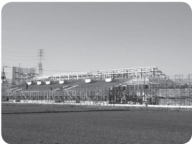
オープンを目指し、着々と工事が進む道の駅
