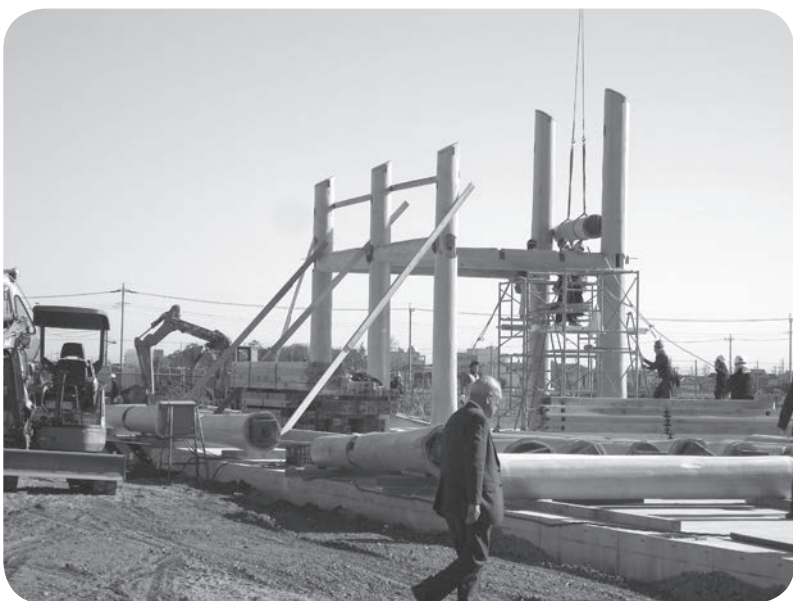
建物の建設が始まった「たまむら道の駅（仮称）」
