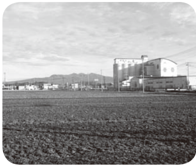
カントリーエレベーター
