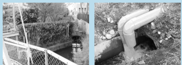
前橋市東善の堰（写真左）で揚水し、通水管（写真右）を通して、年間通水される
