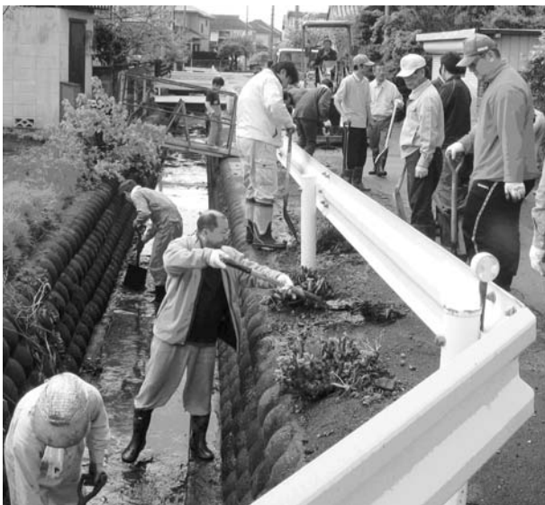
水が流れず悪臭を放つ水路の汚泥除去 を行う地区の方々（4月26日）
