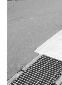
区長からの要望により、補修工事を行った町道
