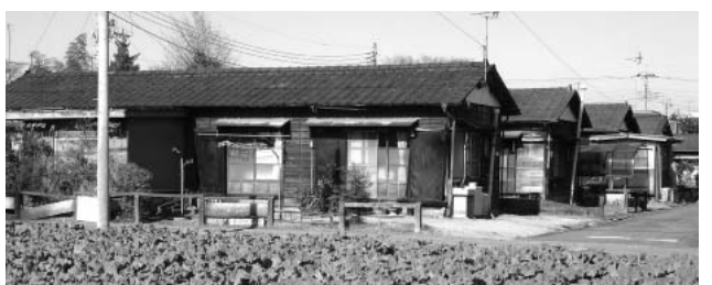
老朽化した町営住宅（福島団地）
