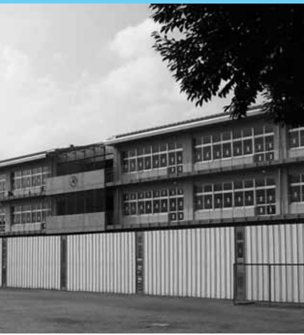
左が解体予定の旧校舎)
