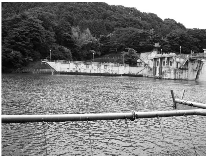
県央第二水道取水口
