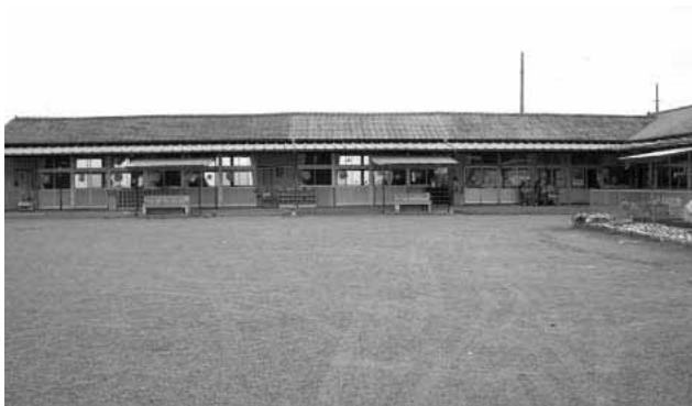
老朽化した第3保育所
