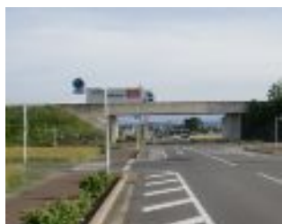
国道 354 号バイパス (高架部分)
