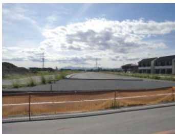
整備が進む東毛広域幹線道路 （国道 354 号バイパス） （仮称）高崎・玉村スマート IC 予定地周辺
