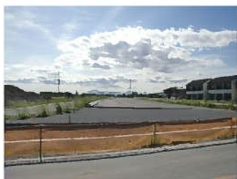
整備が進む東毛広域幹線道路 （国道 354 号バイパス） （仮称）高崎・玉村スマート IC 予定地周辺
