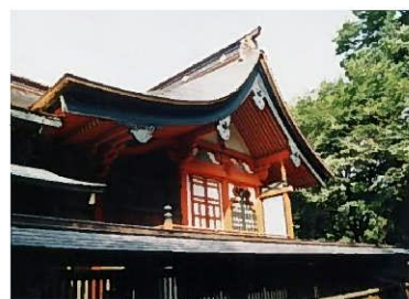
玉村八幡宮本殿 （国指定重要文化財）
