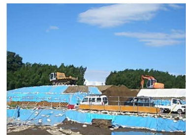
（仮称）利根川新橋の整備 東毛広域幹線道路 （国道 354 号バイパス）
