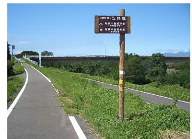
サイクリングロード (五料橋付近)
