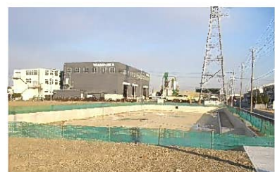
造成が進む東部工業団地周辺
