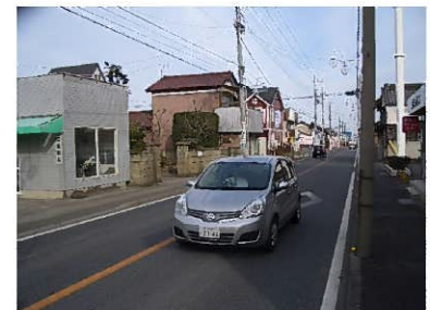
国道354号（日光例幣使道）
