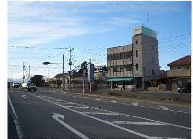
東毛広域幹線道路 (国道354号バイパス)
