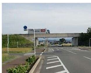
国道 354 号バイパス (高架部分)
