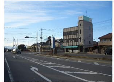
東毛広域幹線道路 (国道354号バイパス)
