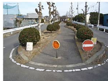
道路の中央にある歩道
