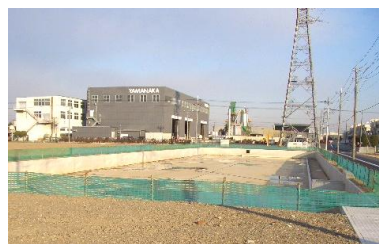
造成が進む東部工業団地周辺
