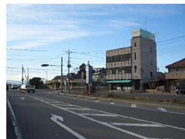
東毛広域幹線道路 （国道354号バイパス）
