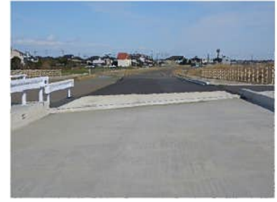
整備の進む東毛広域幹線道路 （仮称）高崎・玉村スマート IC 付近
