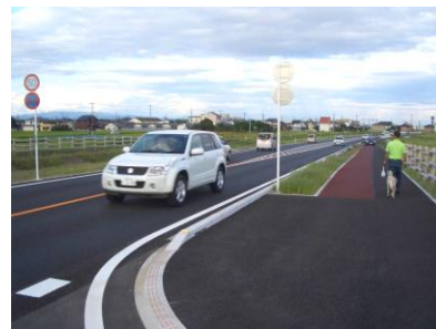
東毛広域幹線道路 (国道 354 号バイパス) 高崎・玉村スマート IC（仮称）予定地周辺
