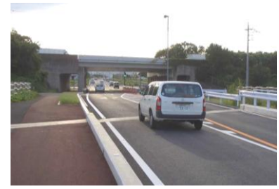
東毛広域幹線道路 （国道354号バイパス） 高崎・玉村スマートIC（仮称）予定地周辺
