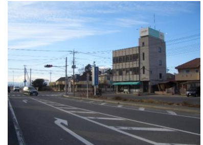
東毛広域幹線道路 （国道354号バイパス）
