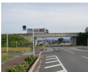
国道 354 号バイパス（高架部分）
