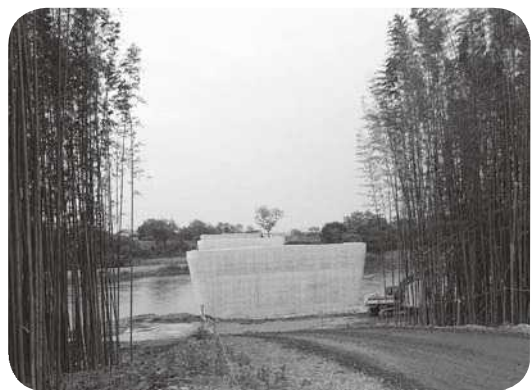
建設中の東毛広域幹線道路 利根川新橋 (完成により交通の利便性向上が期待できる)
