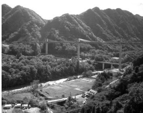
ハツ場ダム建設予定地
