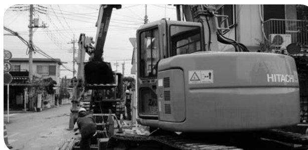
下水道工事現場（板井地区内）
