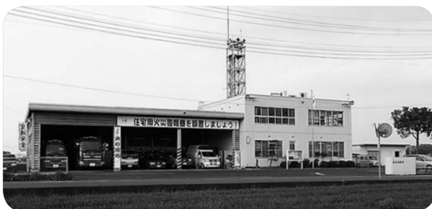
増設が予定されている玉村消防署
