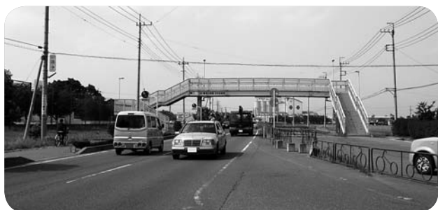
主要地方道路 藤岡・大胡線 中央歩道橋
